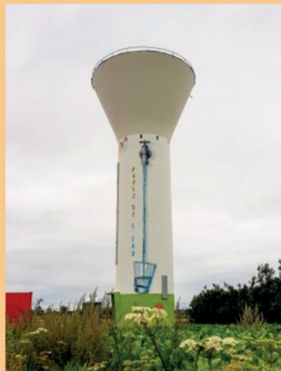
MISE EN PEINTURE DU CHÂTEAU D'EAU
